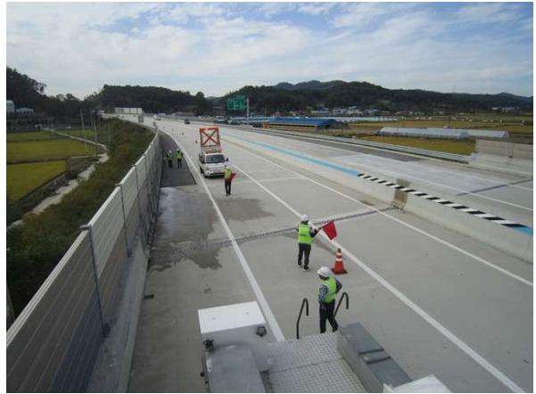
교량 상부 전경
