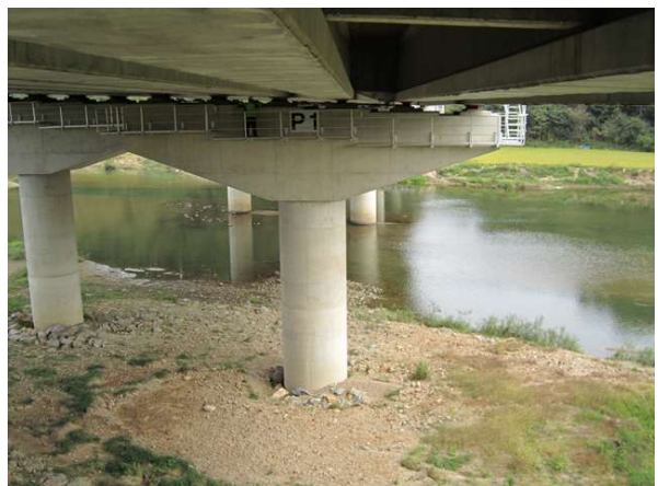
교량 하부 전경
