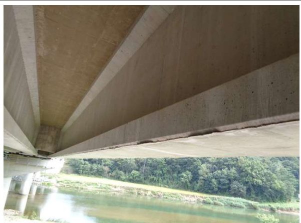
교량 거더 전경
