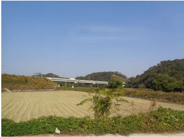
교량 측면 전경
