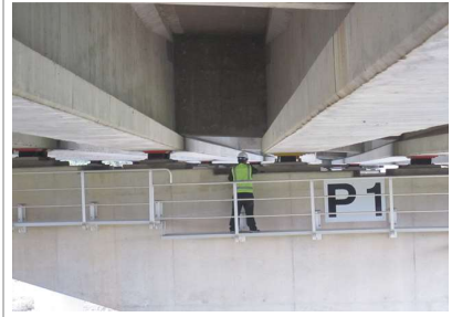
▲ 교량받침 점검로 근접조사
