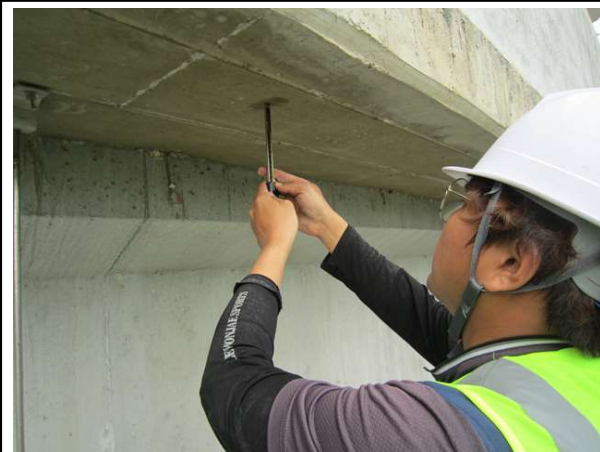
현황 탄산화깊이 측정
