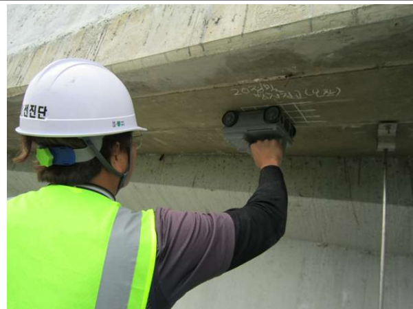
현황 철근탐사 및 피복 측정
