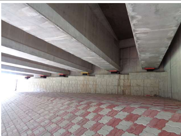
교량 하부 전경
